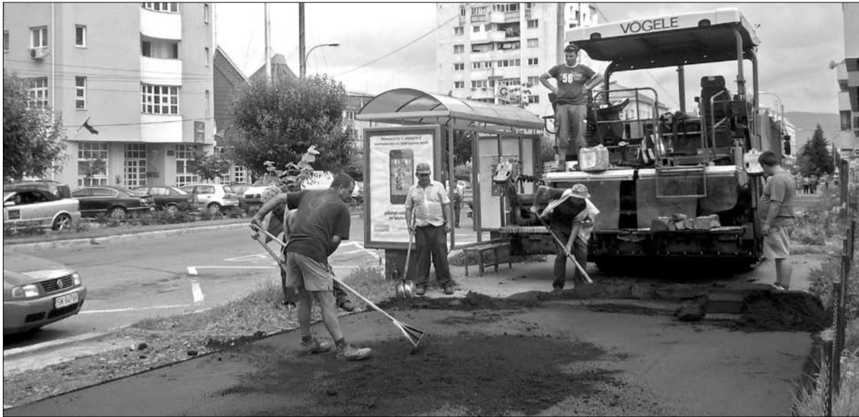
Járdaaszfaltozás a csíkszeredai Kossuth Lajos utcában. Kiegyenlített körülmények
